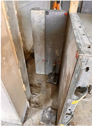
Schalungsarbeiten, um die Pfeiler zu verstärken.
