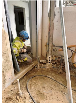
Das Bohren der Mikropfähle ist aufwändig.
